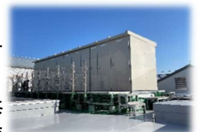
防水工事も同時に実施
